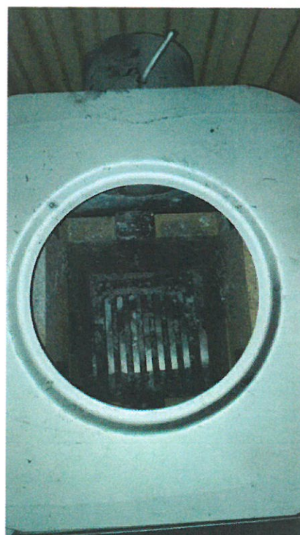
Foto 4. Widok komory spalania
