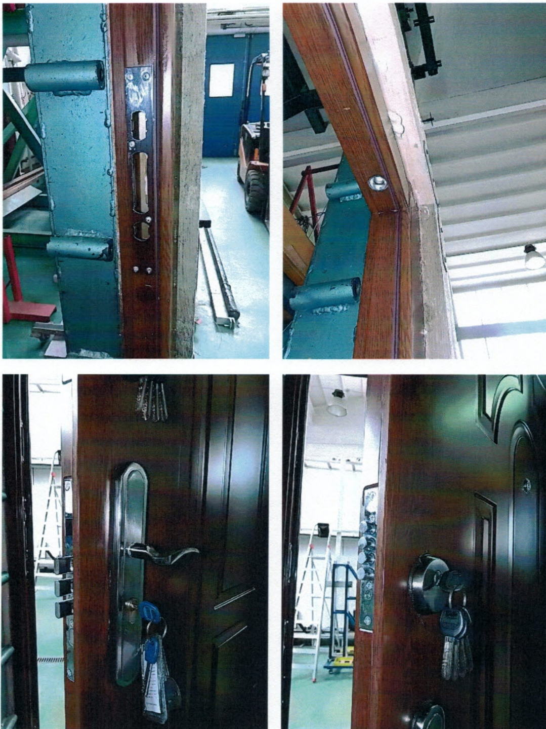
Fot. 4-7. Szczegóły konstrukcyjne.
