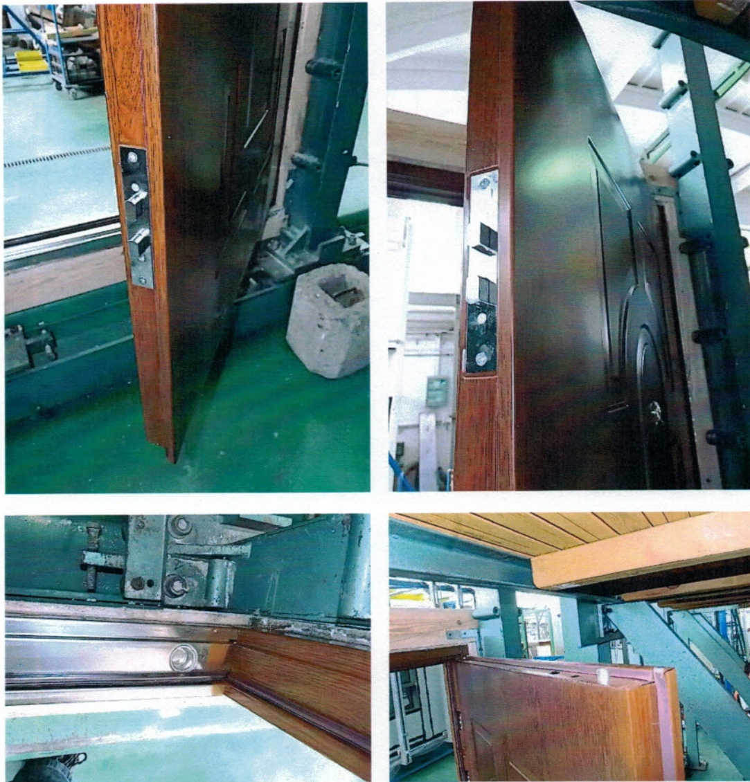
Fot. 8-11. Szczegóły konstrukcyjne.
