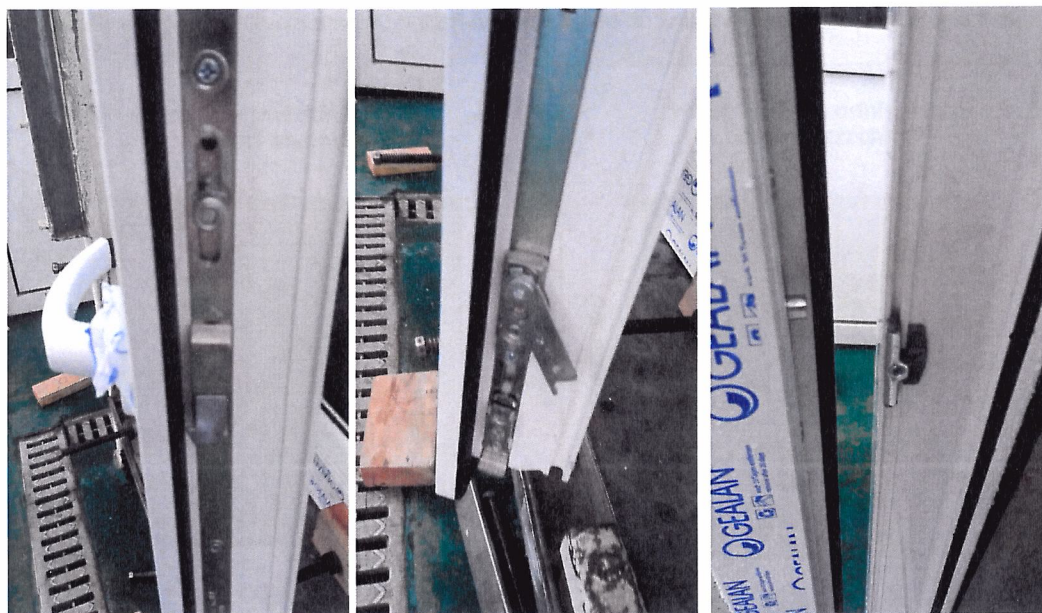
Fot. 2-10. Szczegóły konstrukcyjne.
